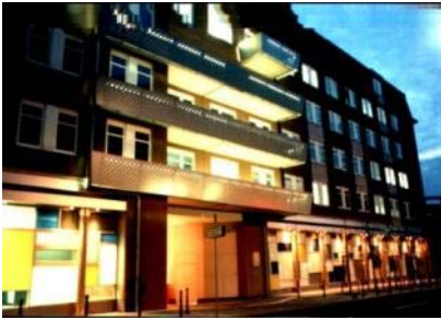
Außenansicht bei Nacht
